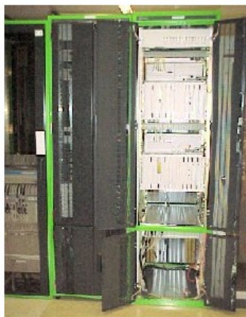
Figuur 20 Standaard KPN 19" kabinet met transmissieapparatuur
